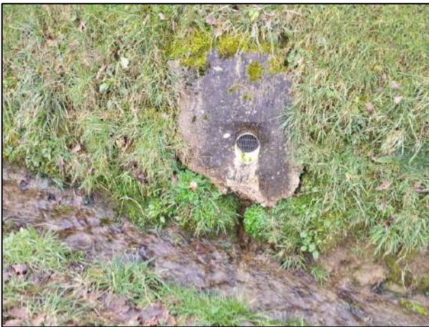
Exemple de rejet d'une parcelle privée vers un fossé communal (eau usée traitée, pas d'anomalie visuelle)
