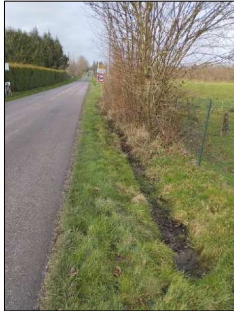
Exutoire d'un réseau d'eaux pluviales – absence d'eau
