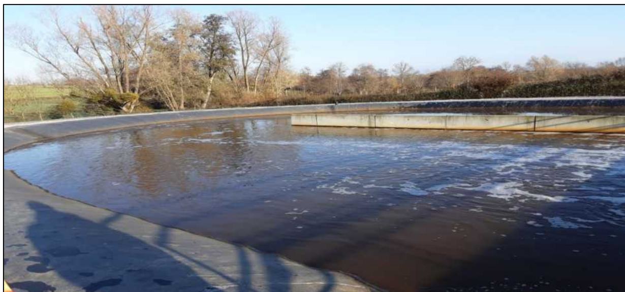
Station de traitement des eaux usées de type lagunage naturel (Altereo – Novembre 2020)
