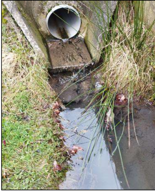
Exutoire de réseau pluvial
