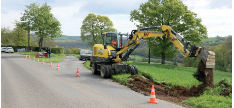
Les travaux ont commencé à la fin du mois d'avril.
