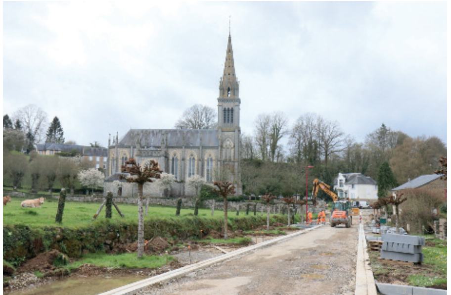
Lors des travaux dans le courant du mois d'avril.
