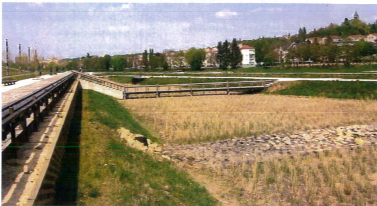
Parc de la Seille Metz (Source SINT) : 2000 m 2 de filtres plantés de roseaux, plan d'eau permanent et bassin sec, 8 000 m 3 de rétention. En fonctionnement depuis 2001. Mise en œuvre paysagère et écologique, au sein d'un parc urbain, de modules de gestion des eaux pluviales d'une ZAC de 45 ha.
