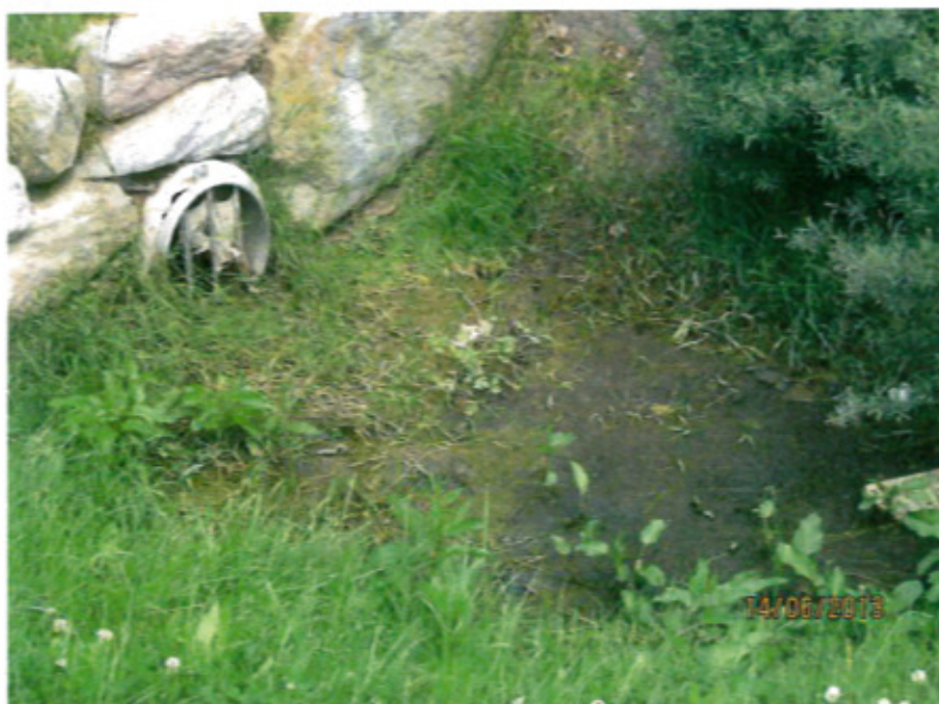
Exemples de mauvais entretien d'une noue
