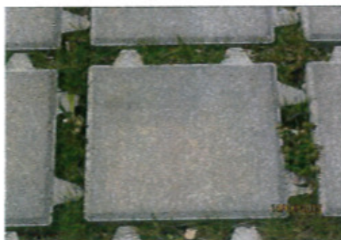
Pavés béton avec joints drainants, Vezin-le-Coquet
